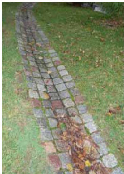
Eksempel på en åben regnvandsrende . Foto fra Augustenborg i Malmø
