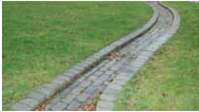
Eksempel på en beholder til videreførelse af regnvand. Foto fra Augustenbog i Malmø
